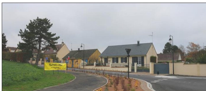
Constructions rue du Jeu d'Arc
