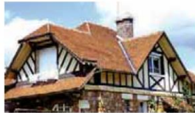
Mouvements de toitures: croupes, noues, ornements sur les rives et les faîtages
