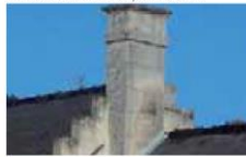
Souche de cheminée en pierre de taille
