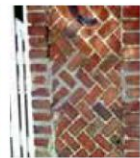
Brique rouge unie, silico-calcaire claire, vermillisée et cintrée, badigeonnée en rouge, posée à chevron, formant un escalier et un couronnement de clôture
