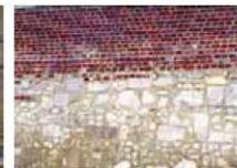
Brique et moellon calcaire
