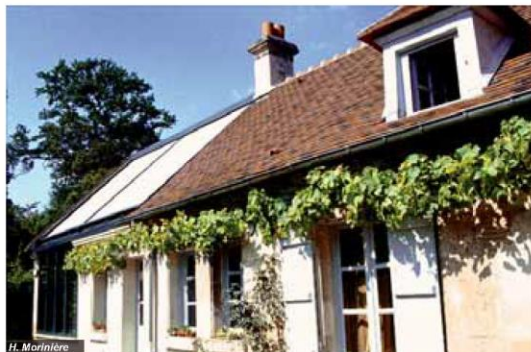
H. Morinière Création d'un espace vitré intégré au volume initial d'une maison rurale
