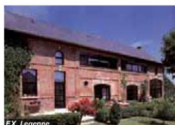
FX. Legenne Rénovation d'une grange du XIX e siècle en habitation conservant la volumétrie initiale et le parement brique
