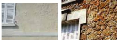
Ravalement d'enduit sur moellon
