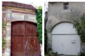
Porche d'entrée avec encadrement ouvragé en pierre
