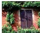
Brique recouverte d'un lait de chaux
