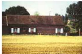
Longero en brique réhabilitée
