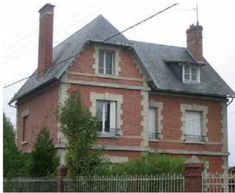
Maison années 1920 en brique et pierre avec une croupe de toiture en ardoise
