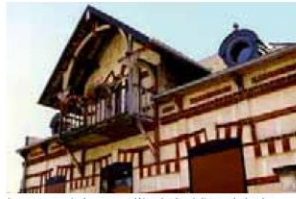
Lucarne centrale avec débord de toiture, boiseries peintes, balcon, lucarne œil de boeuf
