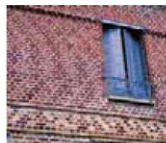
Brique rouge, brique silico-calcaire blanche
